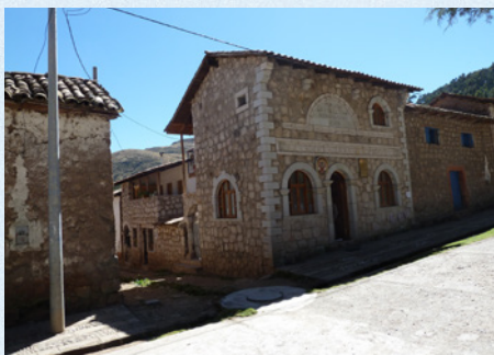
Casa di Mamara - Ricostruita dalla Cooperativa
